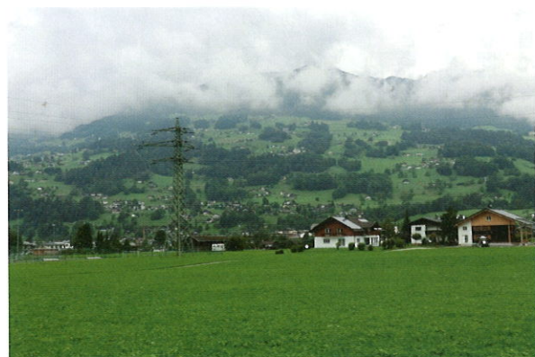
水道配水場への湧水の導水を利用する高落差。少水量の小水力発電所がある給水地区を望む（チロル地方）
